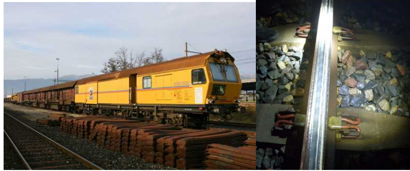
Train meuleur de rails (Scheuchzer S.A.)
