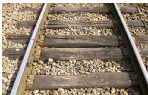
Rails courts sur traverses bois
